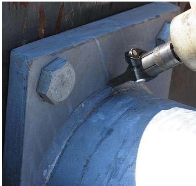
Figure 5.3.2.6 Application of UIT to Baseplate Weld Toe
